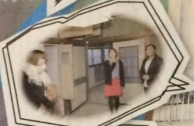
改修中の シェアルームです
